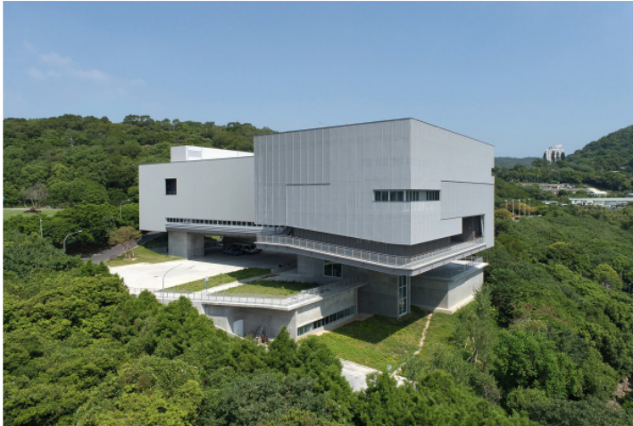
北藝大科藝館建築以抬升設計方式為空間創造懸浮的視覺效果。(郭旭原建築師事務所提供)
